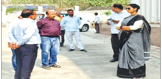
धनाभाव के कारण निर्माण कार्य बंद है। बताया चले कि पर्यटन विभाग द्वारा यूपीएसआईडीसी औद्योगिक क्षेत्र जगदीशपुर में इंस्टीट्यूट ऑफ होटल मैनेजमेंट भवन का निर्माण कराया जा रहा
